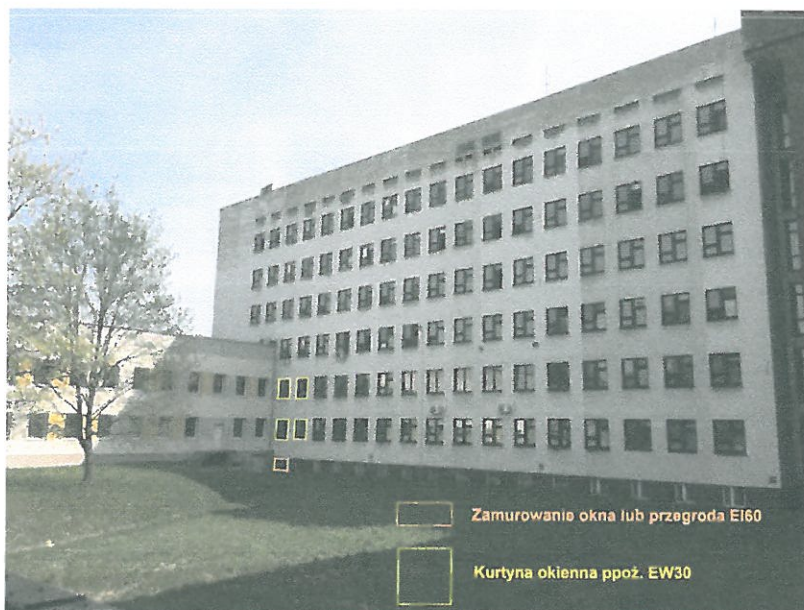
Fot. 8. Blok leczniczy – połączenie z budynkiem Polikliniki (wskazanie okien do zabezpieczenia)
